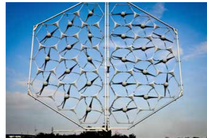
Proof of Concept* und zertifizierte Leistungsvermessung (Germanischer Lloyd) des modularen MOWEA Windenergiesystems
