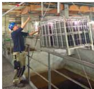
Installation einer MOL@LIK-Einheit im Klarwasserbecken eines Kraftwerkes (Foto: Holger Jentsch)
