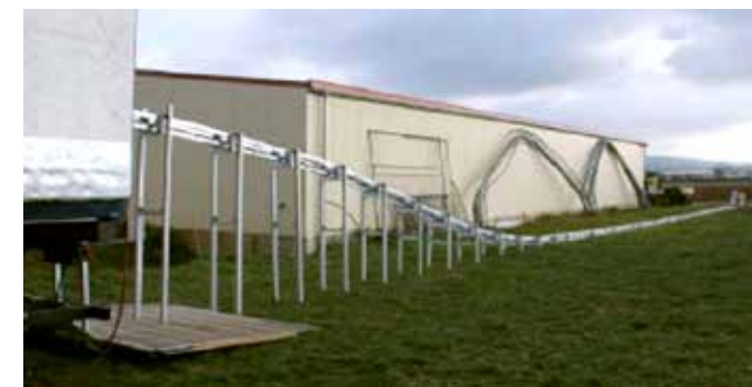
Vor-Ort-Produktionssystem von bis zu 100 m langen Rohrsegmenten der Fa. Algoliner
