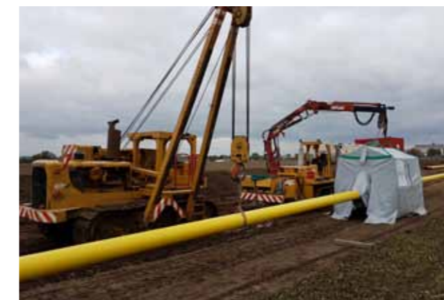
Die Baustellensituation mit durch eine Einhausung geschützter Orbital-Technik
