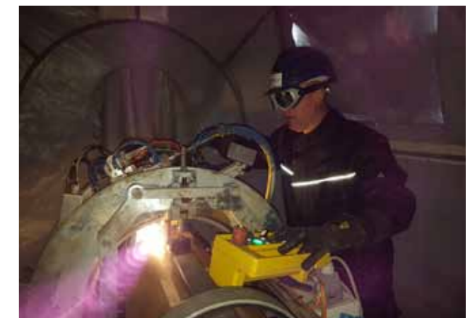
Ein Mitarbeiter der SLV Halle GmbH kontrolliert die Arbeit der Laser-Orbitaltechnik
